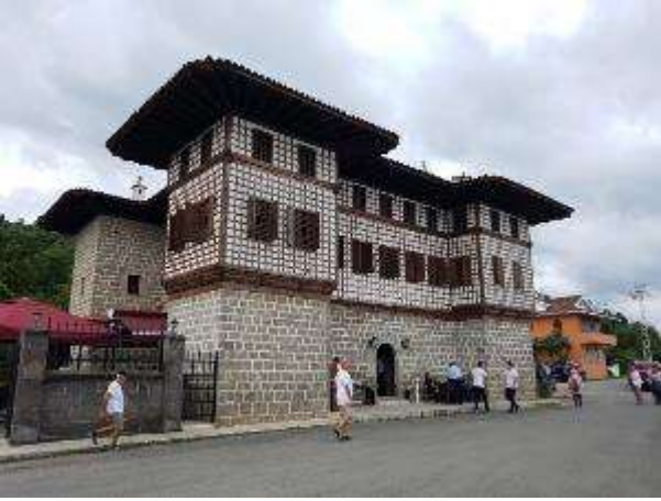
Hacı Yakupoğlu Memiş Ağa Konağı, Kestel Köyü
