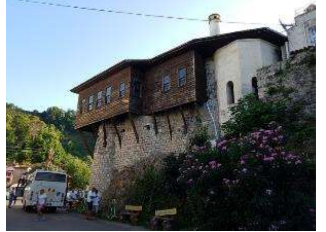
Bolaman Kalesi, Haznedaroğlu Konağı, Perşembe
